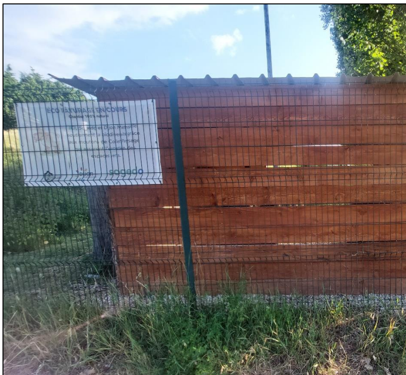
Réservoir semi enterré de Mirande (mise en service en 1976)
