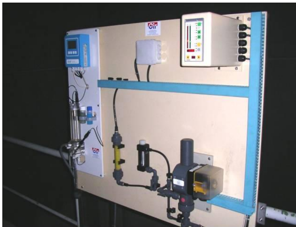
Analyseur de chlore à Mirande
