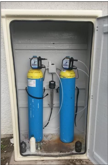
Station de Couteron Armoire de stockage de chlore
