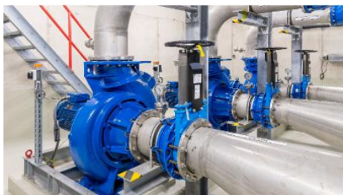
Installation de pompes en cales sèches
