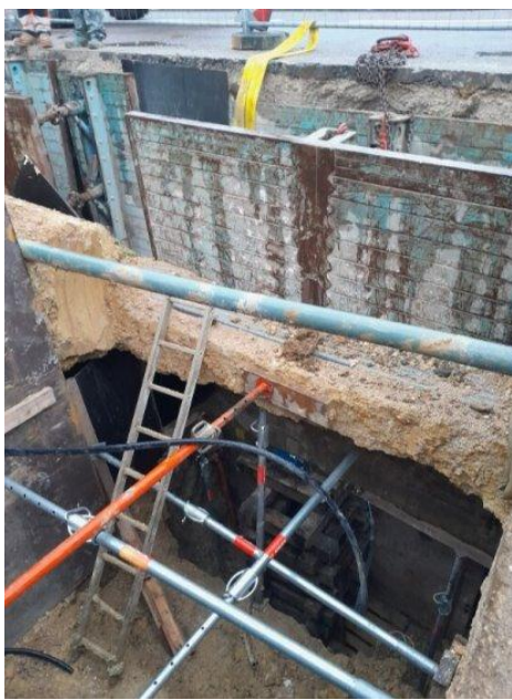
Renouvellement de la canalisation de refoulement du PR ZIN, rue de Mayence Dijon
