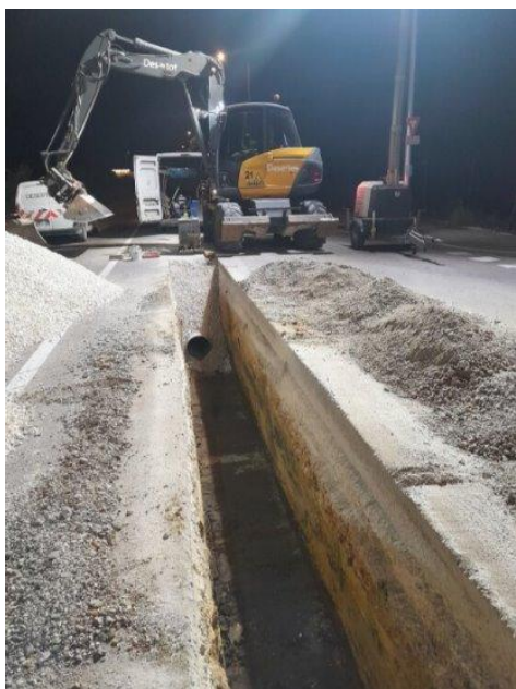
Renouvellement de la canalisation de refoulement du PR ZIN, rue de Mayence Dijon
