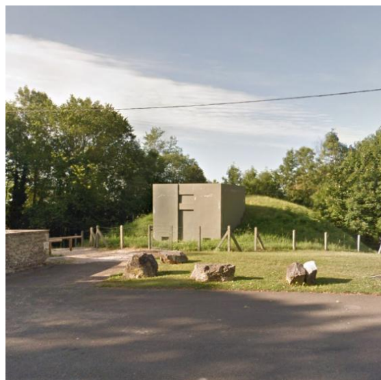
Réservoir de Daix
