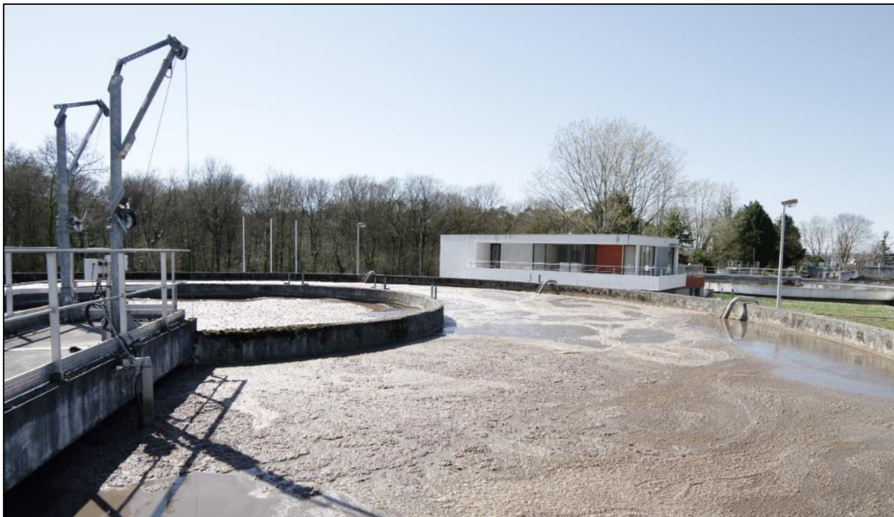
Station d'épuration de Chevigny Saint Sauveur
