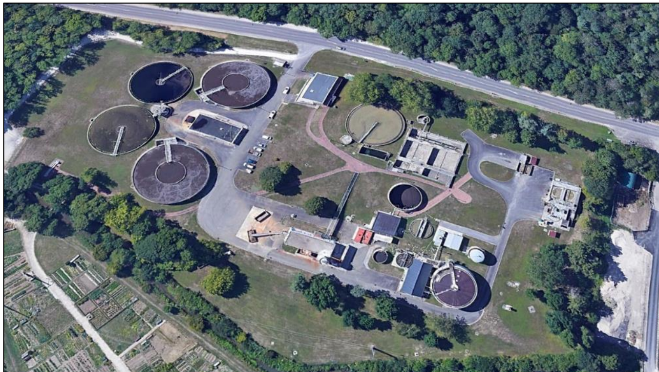
Vue aérienne – Station d'épuration Cheigny Saint Sauveur
