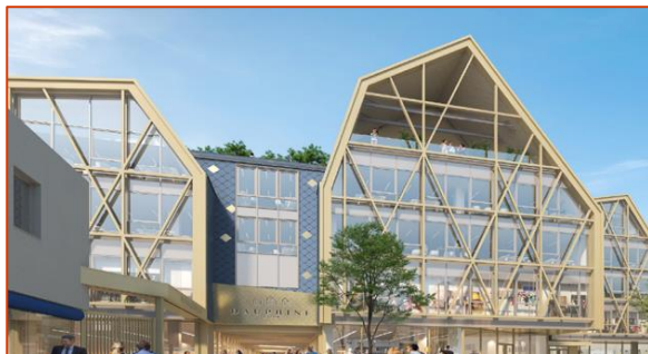
Relocalisation URGO HEALTHCARE – fin 2025 Sur 3000 m 2 SDP - Effectifs : 250 Installation sur le nouveau site Dauphine
