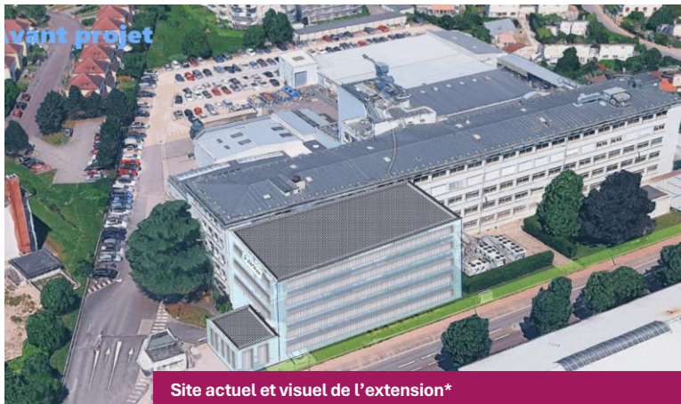
Site actuel et visuel de l'extension*
