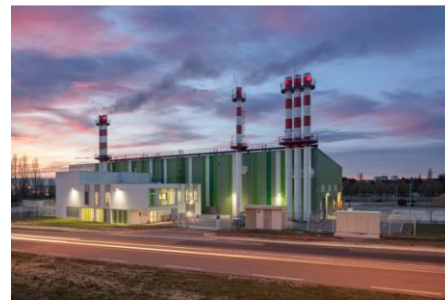
Chaufferie des Péjoces – Dijon Energies
