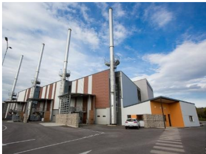
Chaufferie des Valendons - SODIEN
