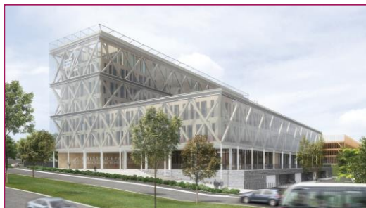
Inauguration siège Caisse d'Epargne BFC 8 octobre 2024 Implantation sur 9500 m 2 SDP – Effectifs : 400 Dijon VALMY
