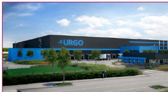
Livraison site URGO 9 octobre 2024 Site additionnel sur 16 000 m 2 SDP Zone d'activités de Beauregard
