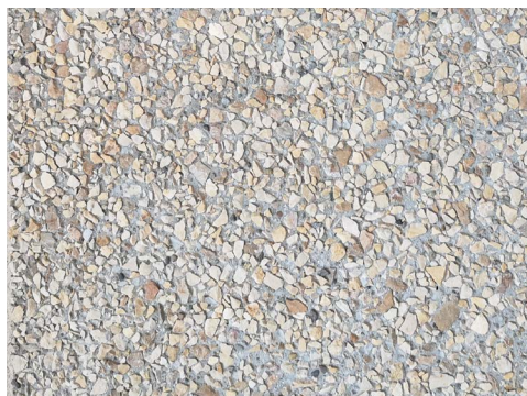
Béton désactivé → Trottoir
