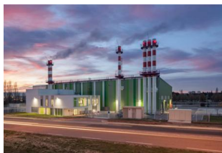
Chaufferie des Péjoces – Dijon Energies
