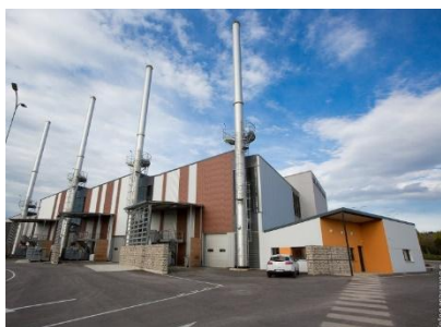
Chaufferie des Valendons - SODIEN
