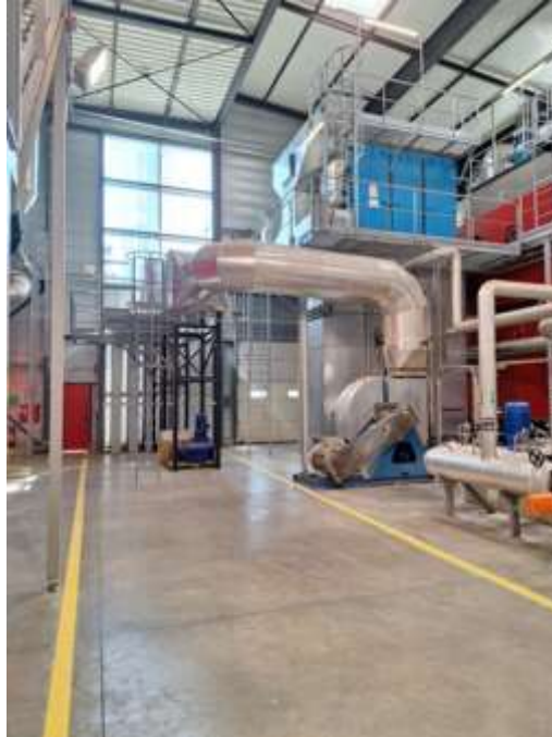
Figure 4 : Emplacement actuel disponible pour implantation futur du condenseur de fumées
