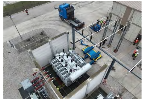
Mutation de transformateur au poste source "Coubertin"
