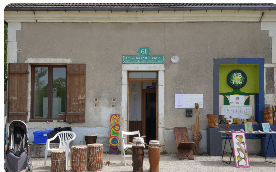
Ecluse 61S à Ouges ©Ville de Dijon/Dijon Métropole
