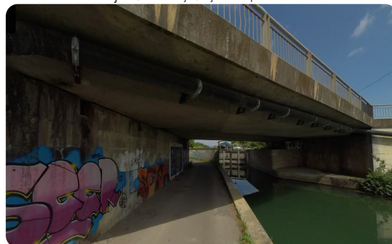
Passage véloroute sous pont à proximité du Boulevard Kennedy à Dijon ©Ville de Dijon/ Dijon Métropole
