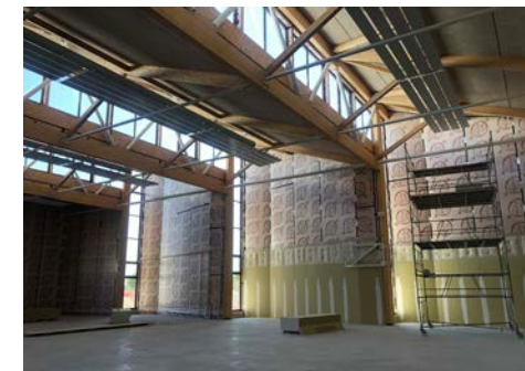
Construction du Gymnase - Septembre 2025 ©Dijon Métropole
