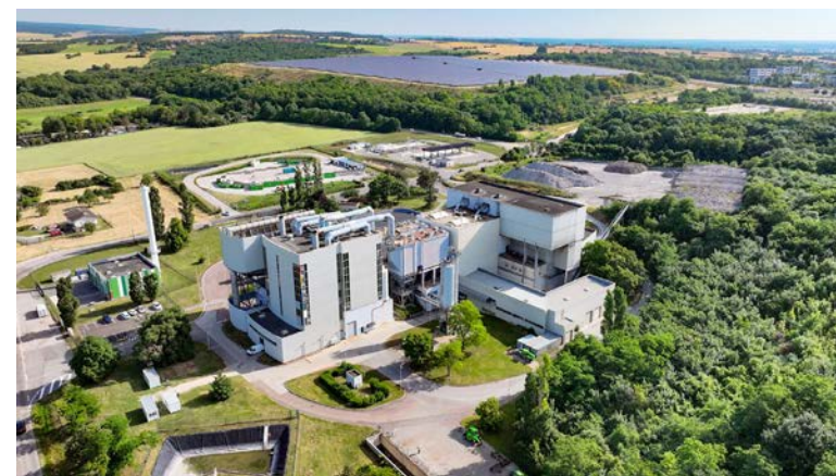
Usine de Valorisation Énergétique-Juin 2025 ©Emma Benyamini/ Ville de Dijon
