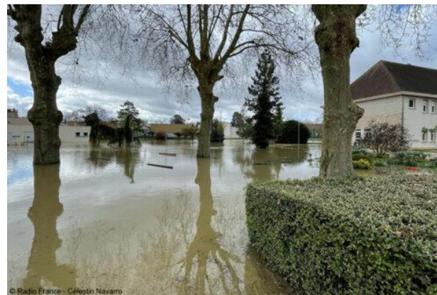
Centre Hospitalier La Chartreuse, crue de l'Ouche 2024
