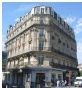
Immeuble de type haussmannien
